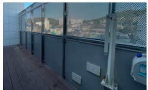
외부경관 조성 공사
