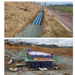
관로 및 기능성 펌프실 시공
