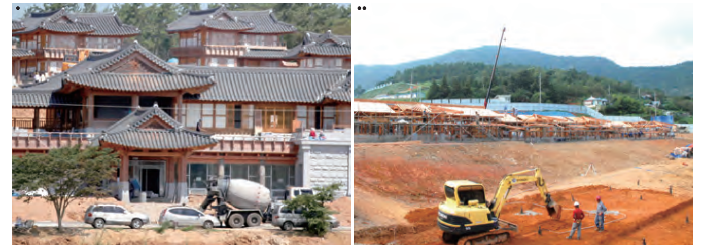
● 영산재 건립공사 현장 ● 오동재 건립공사 현장
