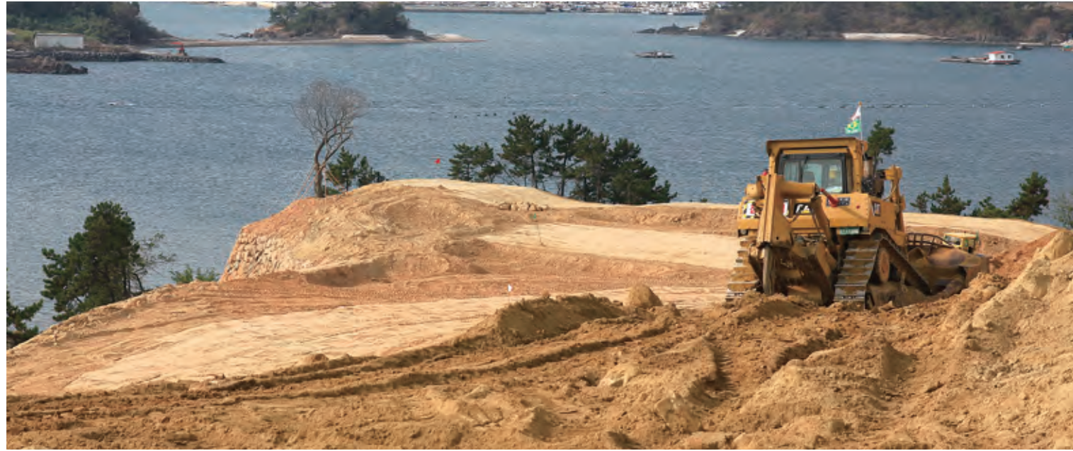
● 여수경도해양관광단지 초기 공사단계
