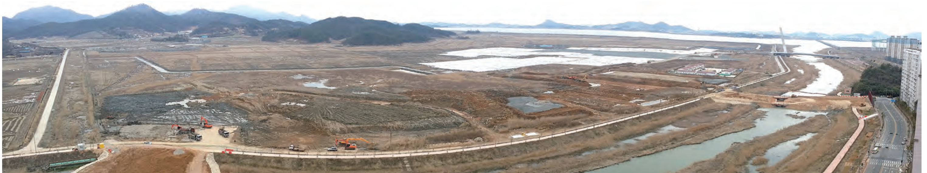
● 오룡지구 개발 공사현장
