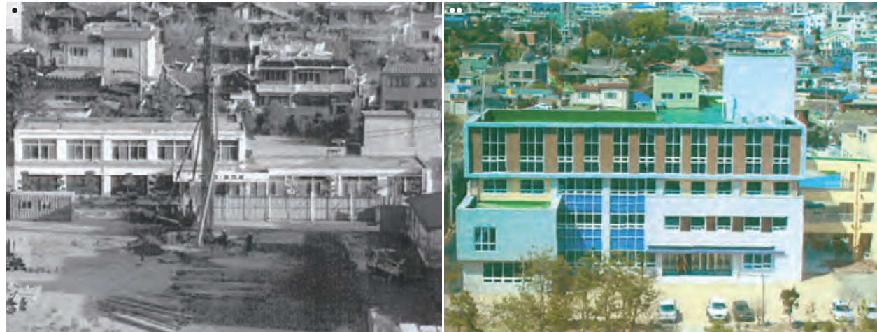
● 순천의료원 노인성질환 전문병동 건립공사 전(前) ● 후(後) 모습
