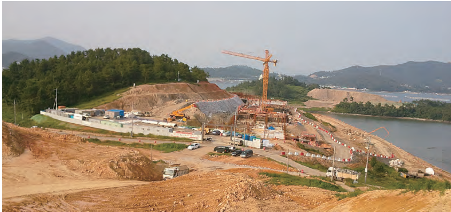
• 여수경도해양관광단지 개발 초기 현장
