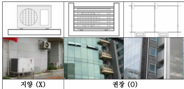
[그림37] 실외기 설치 예시도
