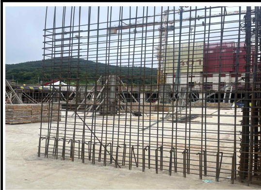
벽체 폭 고정근 시공간격 준수(@1200)
