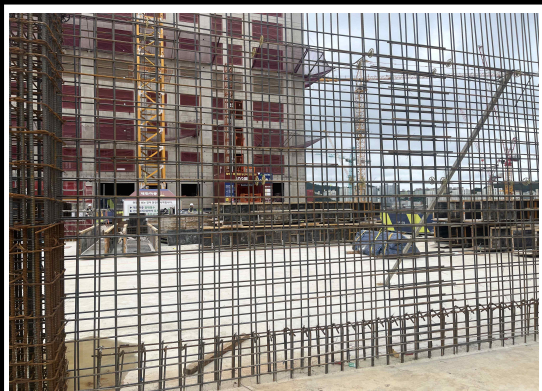
벽체 철근 스페이서 시공간격 준수(@1500)
